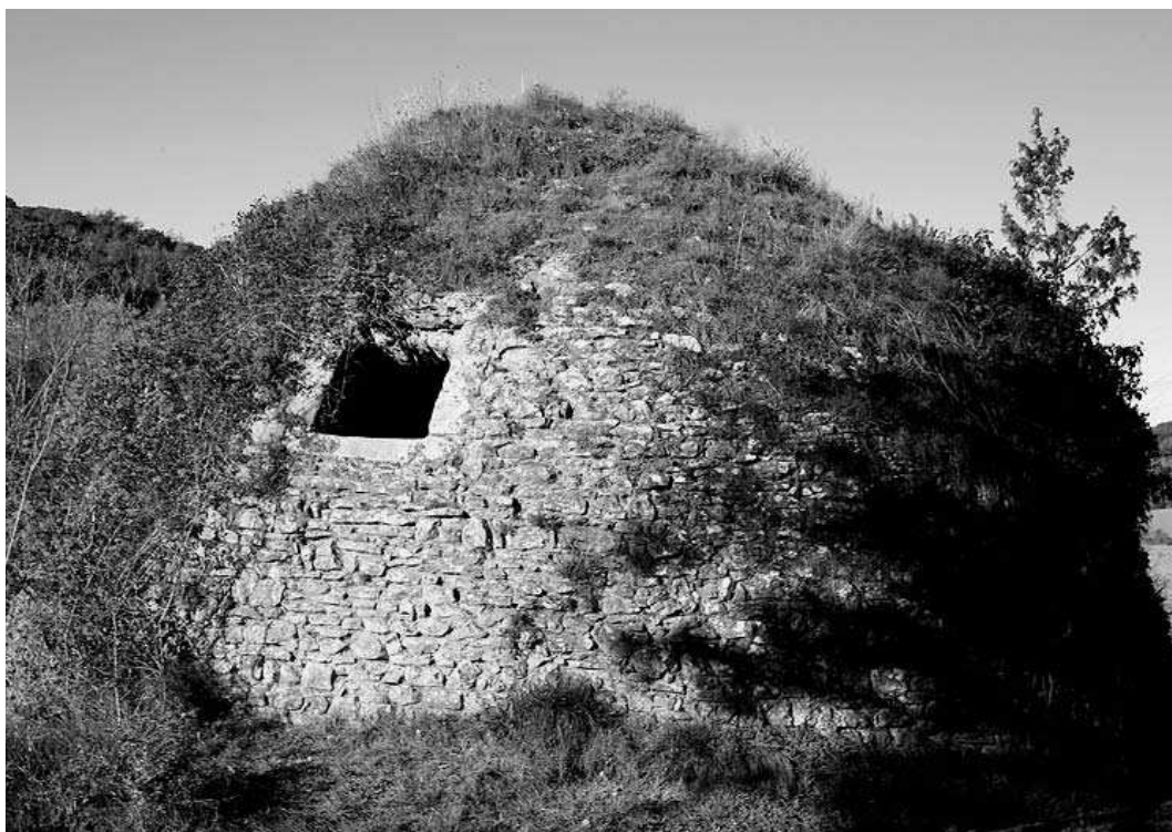
Poua de cal Revitllat, Castellerçol.
